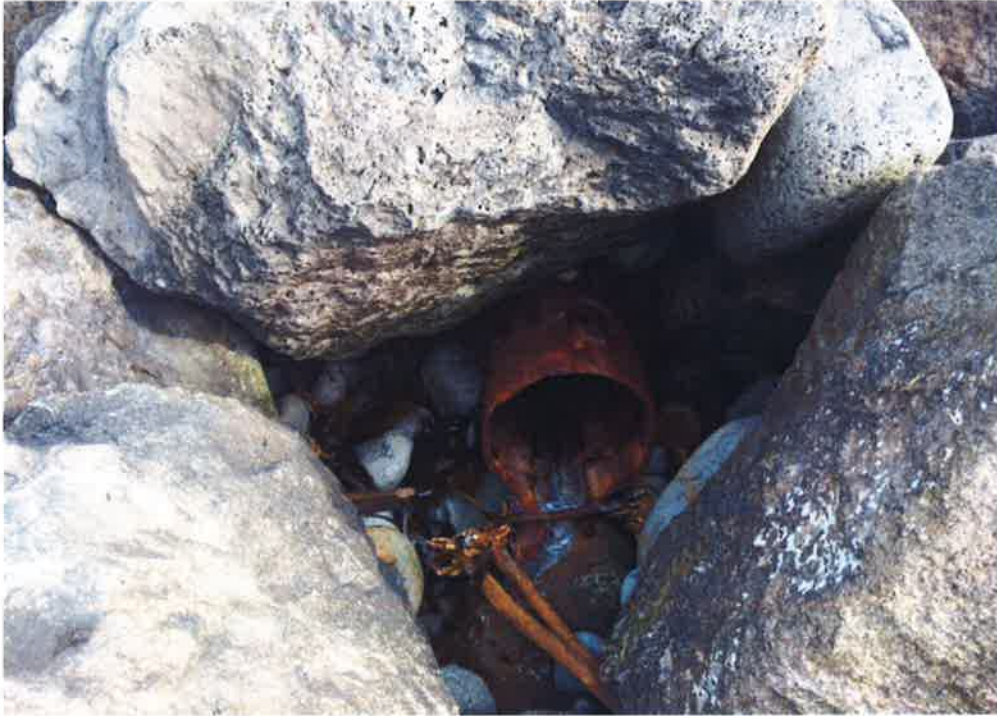
Mynd 2-26 Útrás 2, Brimnesvegur
